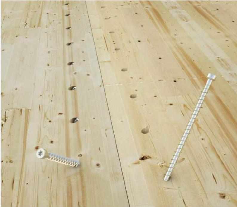
Verbindungen mit sehr hoher Steifigkeit nebeneinander liegender BSP- Deckenbalken. Anwendung mit doppelter 45°-Neigung, ideal mit Montagelehre JIG VGZ herzustellen.
