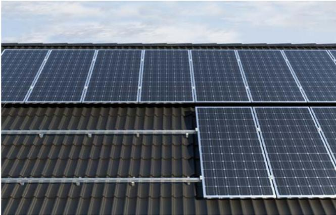
Das fischer Sortiment ermöglicht die Befestigung von Photovoltaikanlagen auf Steildächern aus Ziegel mit oder ohne Belüftungstreifen.
