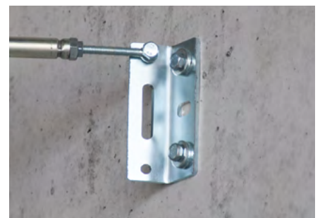
Befestigung von Wandhaltern und Konsolen
