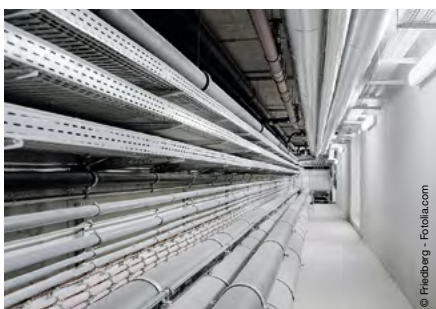
Befestigung von Kabelschächten
