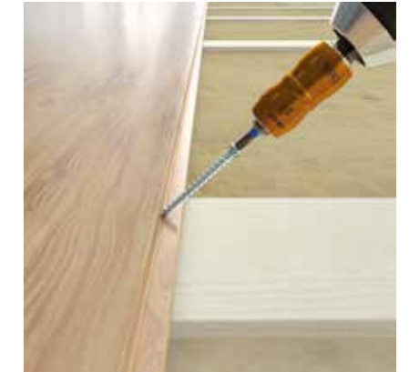
Fixierung von Dielenbelag
