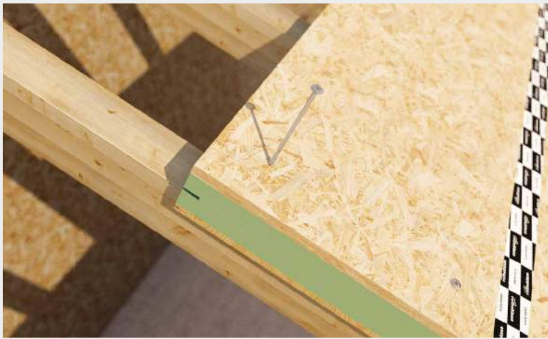
^ Befestigung von SIP-Platten mit 8 mm TBS-Schrauben.
