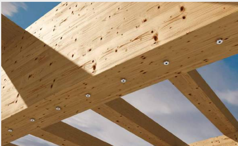
Verstärkung rechtwinklig zur Faser eines großen Lamellenholzträgers.
