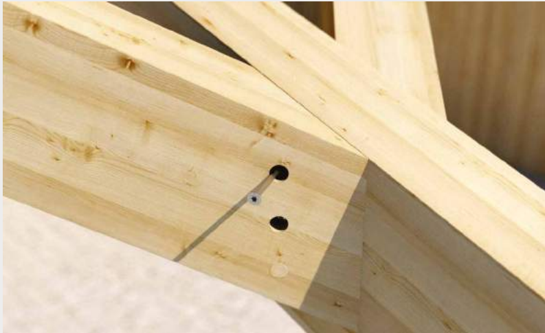
Verbindungen Balken-Dachkehle mit HBS-Schrauben, Durchmesser 8 mm.
