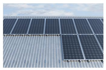
Das fischer Montagesystem für Trapezblechuntergründe ermöglicht die sichere Montage von Photovoltaikanlagen auf Wohn-, Gewerbe- und Industriedächern.
