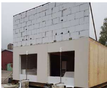
Foto des Abschnitts nach der Montage, vor Beginn des Tests
