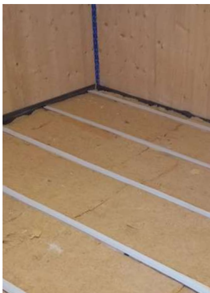
Einbau des Trockenbausystems mit PIANO
